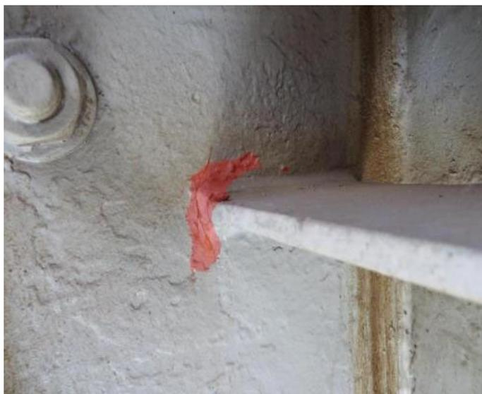
Пример распознавания нейронной сетью трещины в зоне сварного шва
