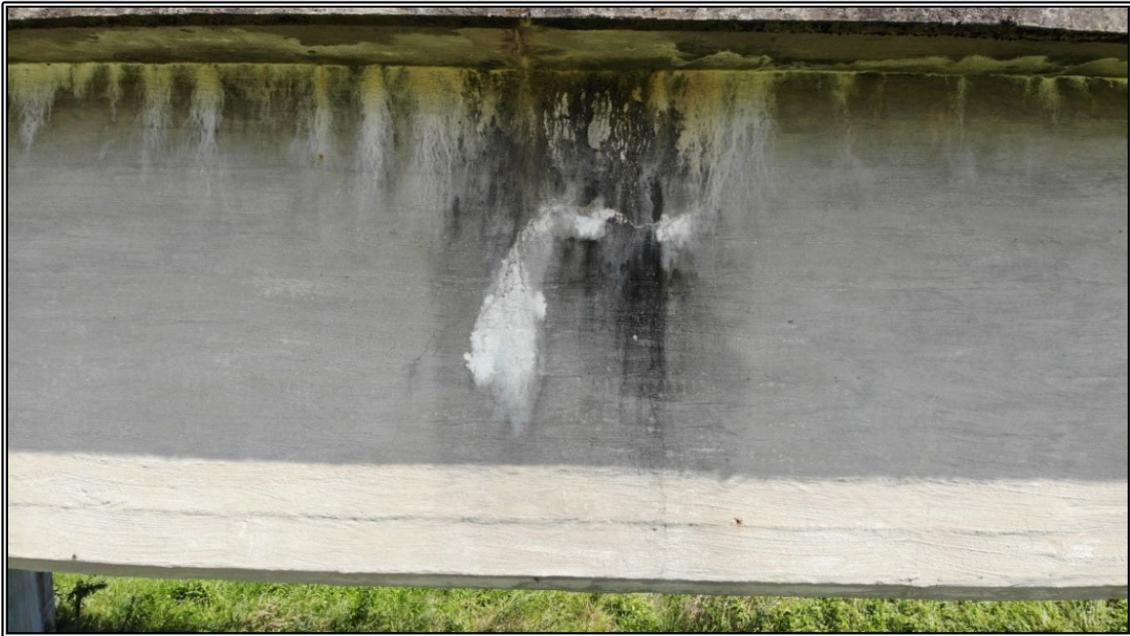
Обводнение пролетного строения и тротуарной консоли (высота ~ 8 м)
