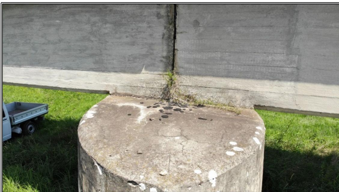
Верхняя поверхность опоры и стыковка с пролетным строением (высота ~ 7 м)
