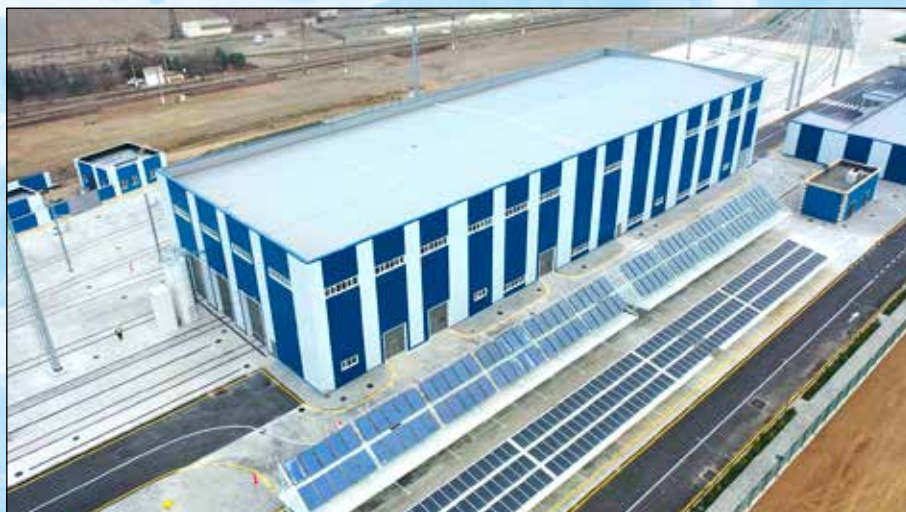
在环保政策框架下比拉贾里和占贾两座城市的机车库安装了太阳能电池板
