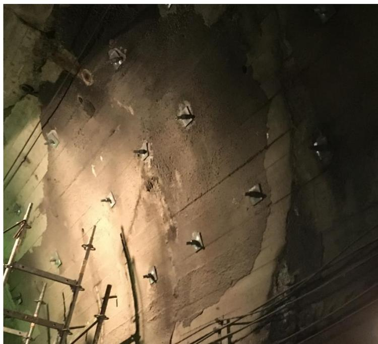
Рис. 5. Обделка тоннеля усиленная анкерами
