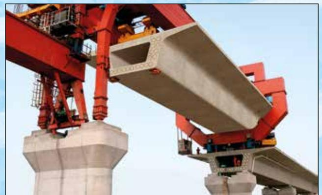
Montage vom Freitragbalken mit einem Gewicht von 900 Tonnen und einer Länge von 32 m auf der Hochgeschwindigkeitslinie der Chinesischen Eisenbahnen
