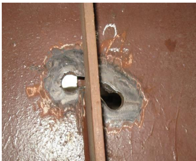
Рисунок 5.2. Разделка трещины.
