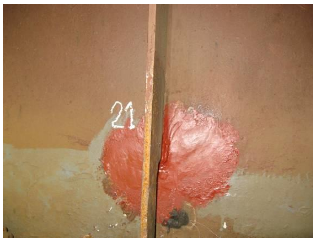
Рисунок 5.4 Окончательный вид после ремонта
