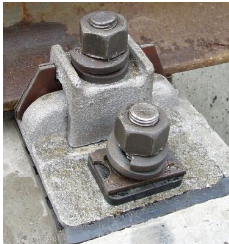
Рисунок 3.1– Раздельное крепление типа СКД65-Б
