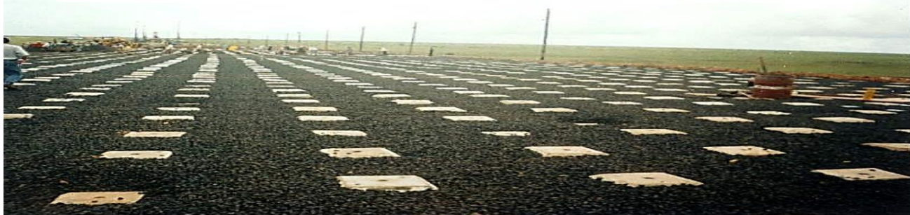
Устройство гибкого ростверка
