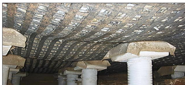
Свайное основание гибкого ростверка
