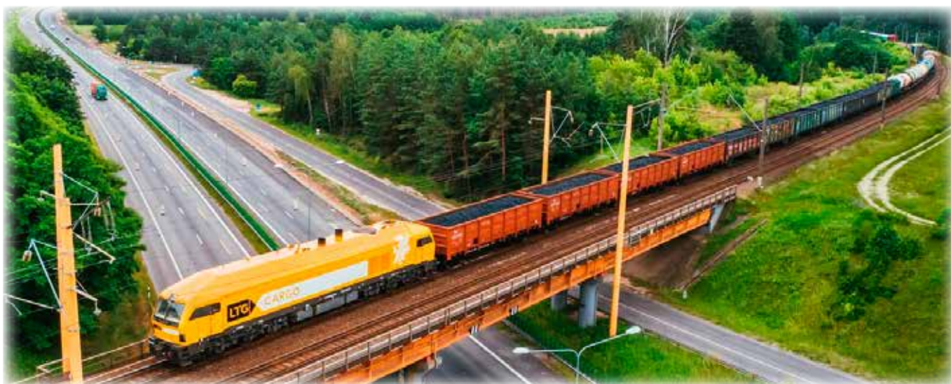
Железнодорожные перевозки LTG Cargo по коридору ОСЖД № 13 铁组第13走廊上的立铁货运公司的铁路运输 Transportation of goods by LTG Cargo along OSJD corridor No. 13 Eisenbahngütertransport von LTG Cargo entlang des OSJD-Korridors Nr. 13
