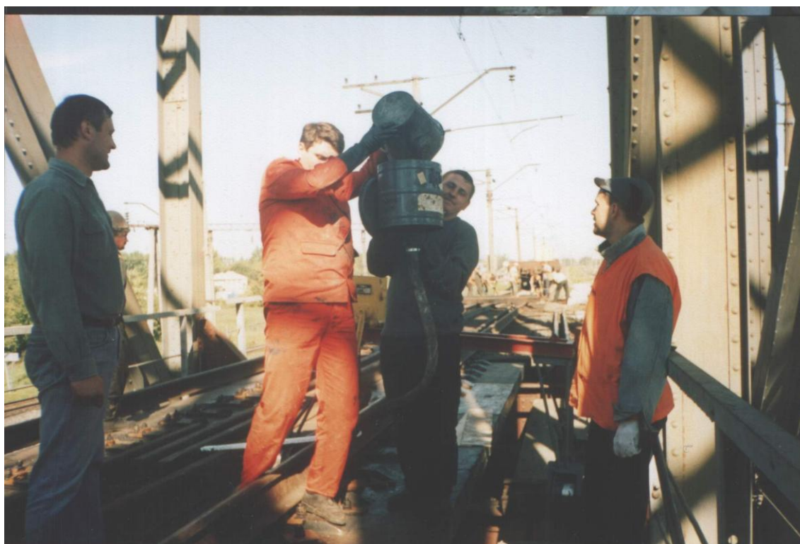
Фото 4. Заливка полимеркомпозиционного состава под плиты БМП из специального приспособления через отверстие под шпильку
