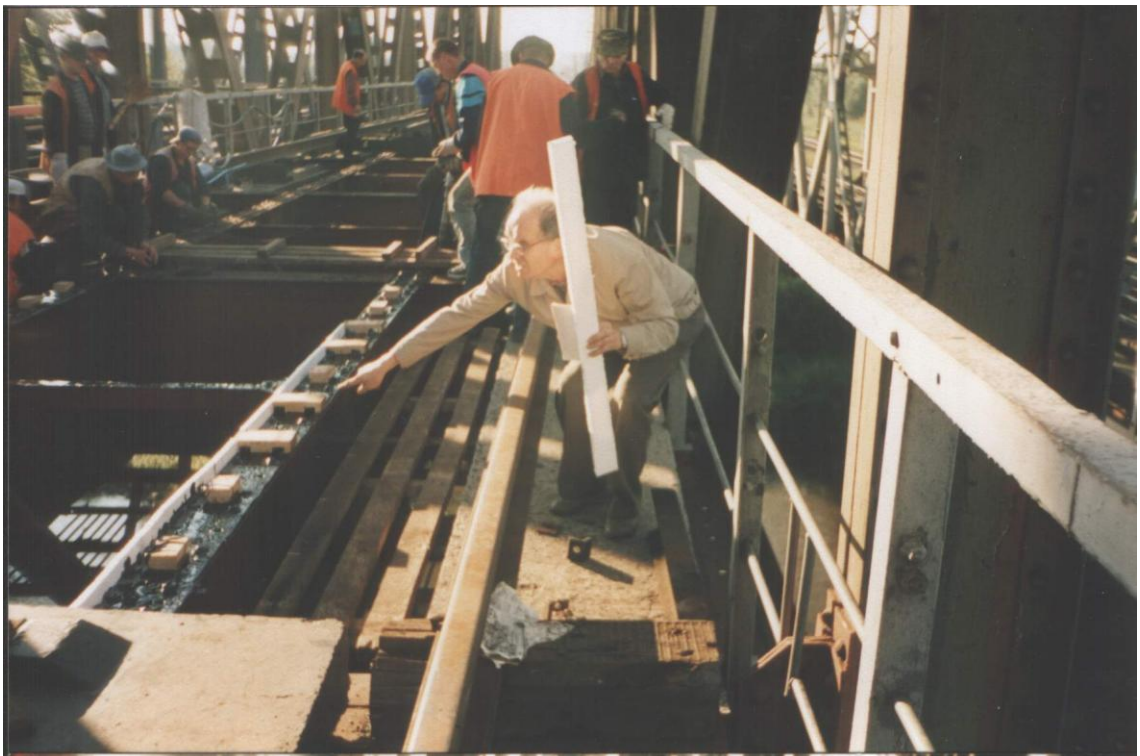
Фото 2. Продольный борт опалубки и опорные бруски перед укладкой плит
