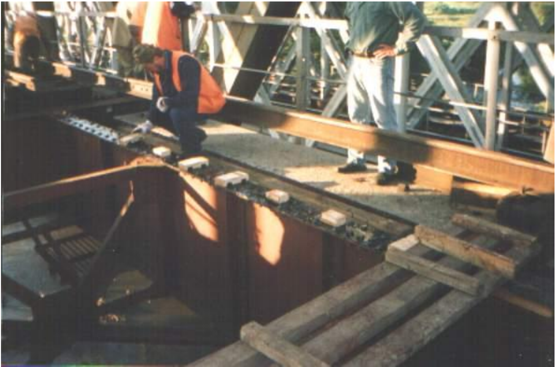
Фото 1. Установка опорных брусков
