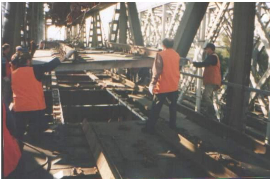
Фото 3. Укладка плит БМП
