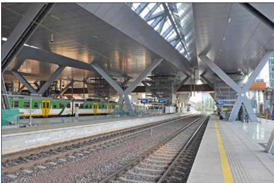
Железнодорожный вокзал «Варшава-Заходня» (Западный) после реконструкции
