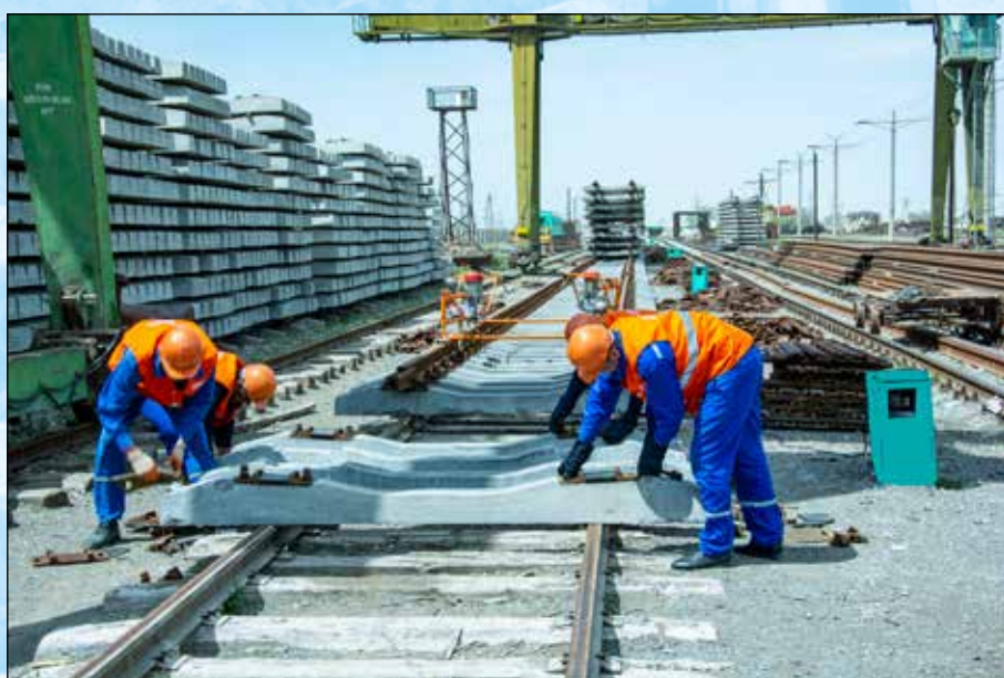
Работы по строительству новых железнодорожных линий
