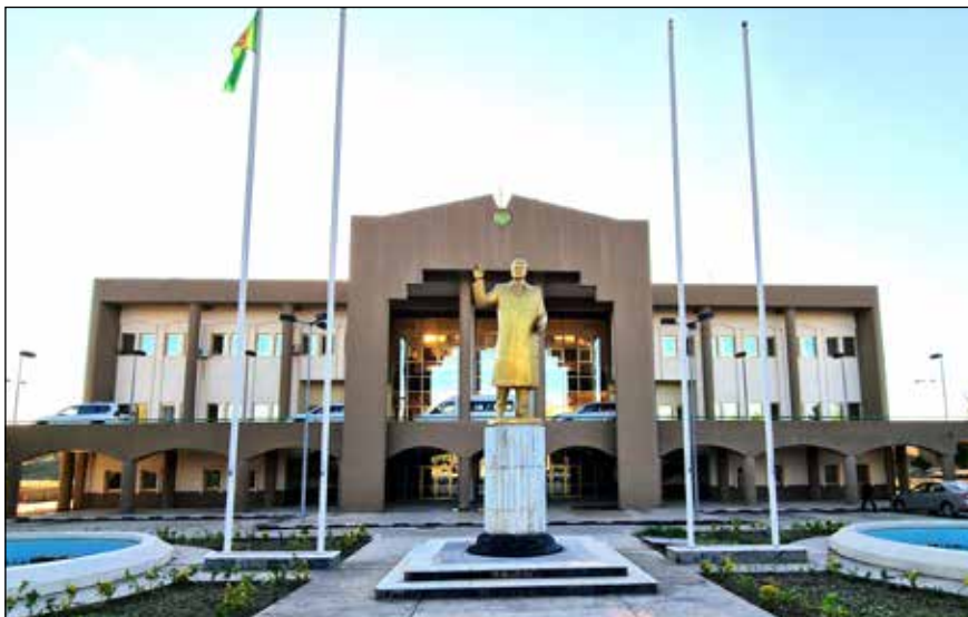
Здание вокзала на станции Сарахс оборудовано всеми необходимыми техническими средствами контроля и помещениями для организации трансграничного пассажирского сообщения
