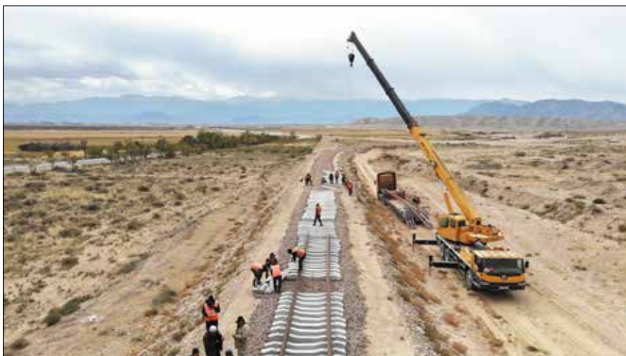
Строительство новой железнодорожной линии
