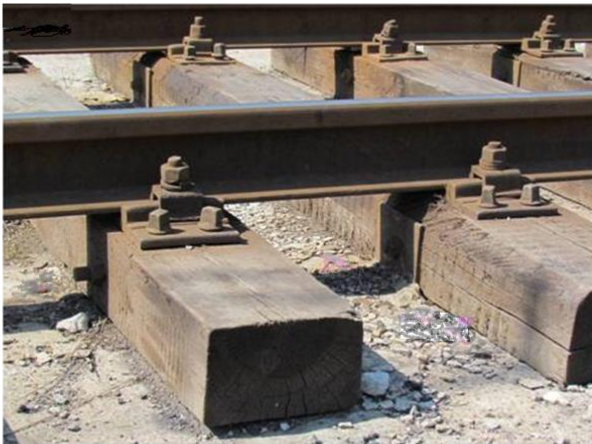
Рис. 13. Укладка брусьев с непосредственным опиранием на железобетонную плиту пролетного строения.
