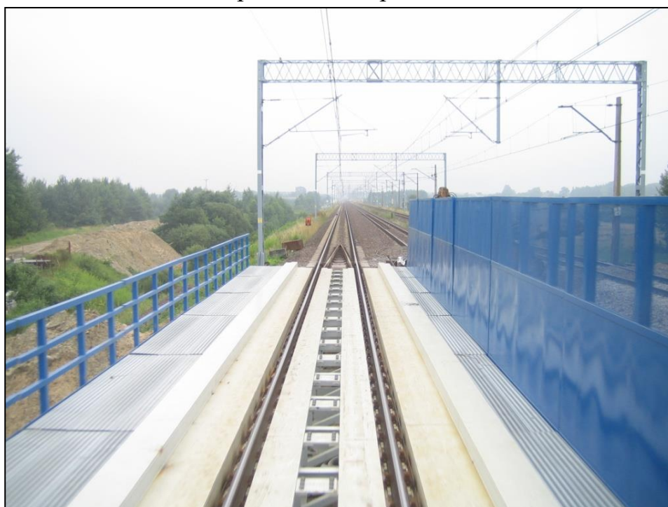
Рис. 32. Общий вид мостового полотна на временном пролетном строении
