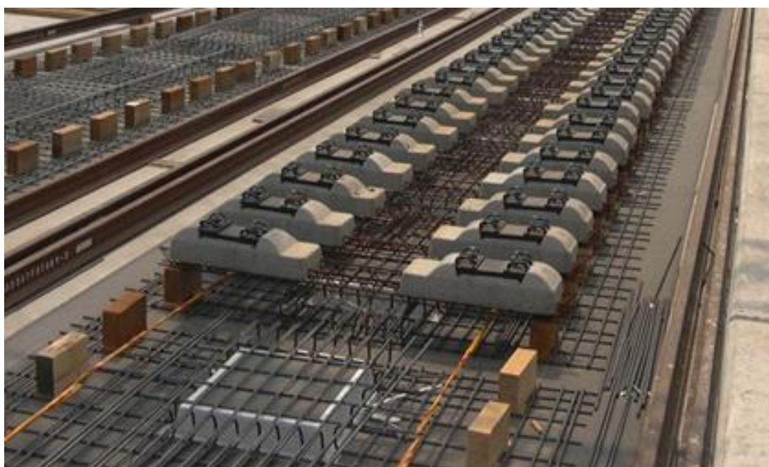
Рис. 21. Путь установлен в проектное положение перед укладкой бетона
