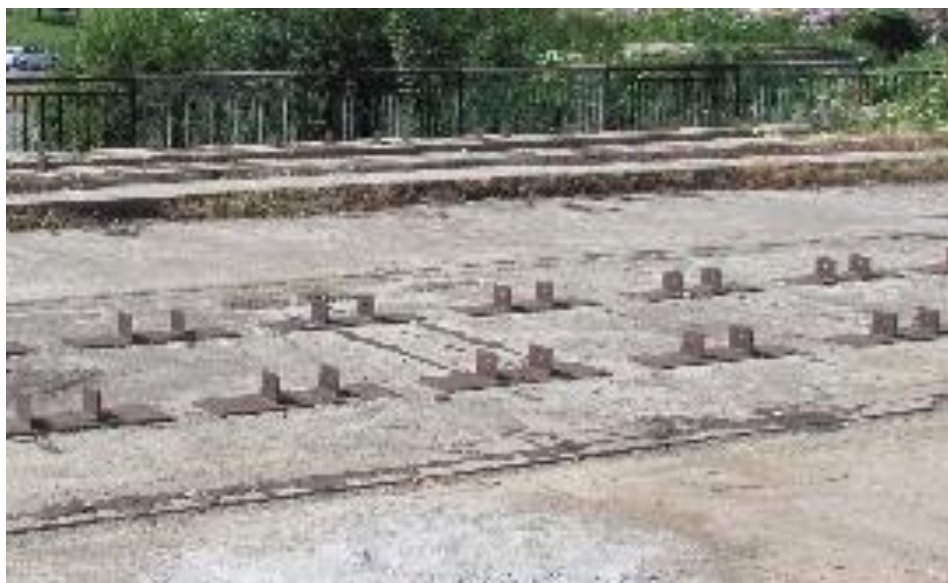
Рис. 12. Металлические конструкции для непосредственной укладки мостовых брусков на железобетонную плиту.
