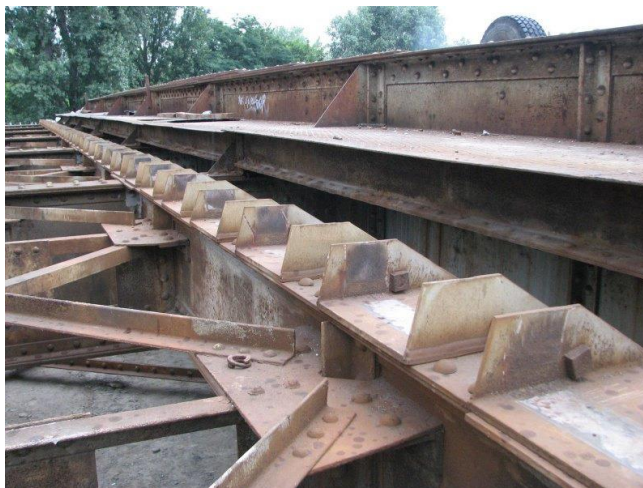
Рис. 22. Башмаки шпал на верхнем поясе продольной балки.
