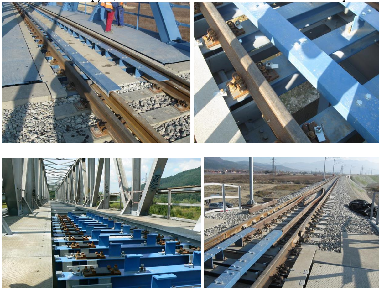
Рис. 17. Общий вид мостового полотна на металлических поперечинах типа «I» от компании Thyssen Krupp.
