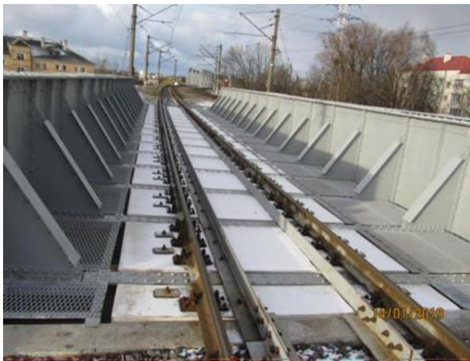
Рис 33. Общий вид мостового полотна на композитных плитах.
