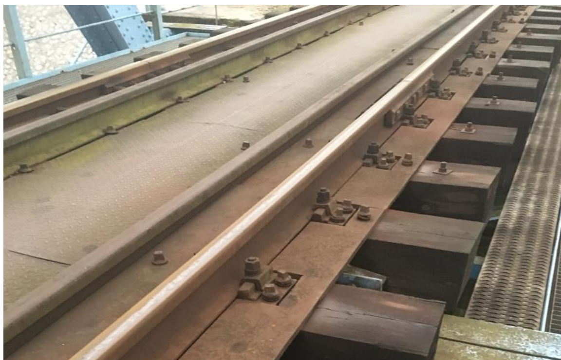
Рис 1. Общий вид мостового полотна с защитой стальным листом.
