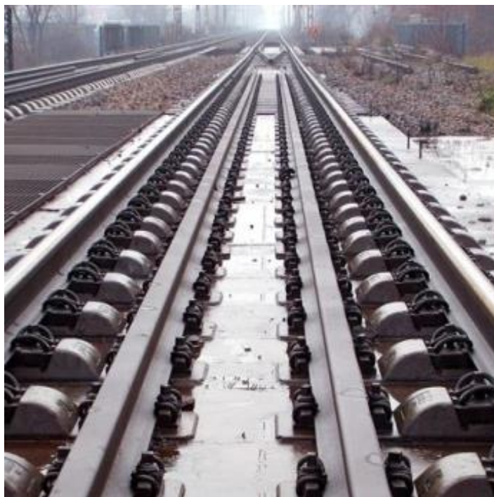
Рис. 22. Общий вид пути на мосту
