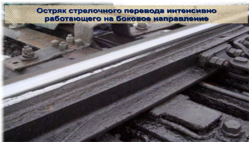
Рисунок 4.2 - Интенсивный износ остняка
