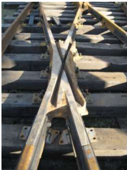
Рис. 3. Тупая цельнолитая крестовина глухого пересечения
