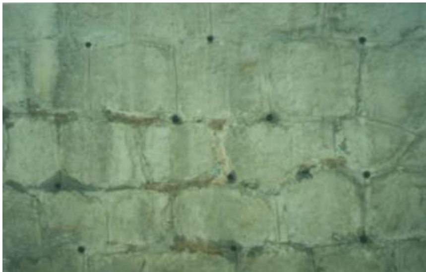
Рис 5. Скважины для цементации опоры
