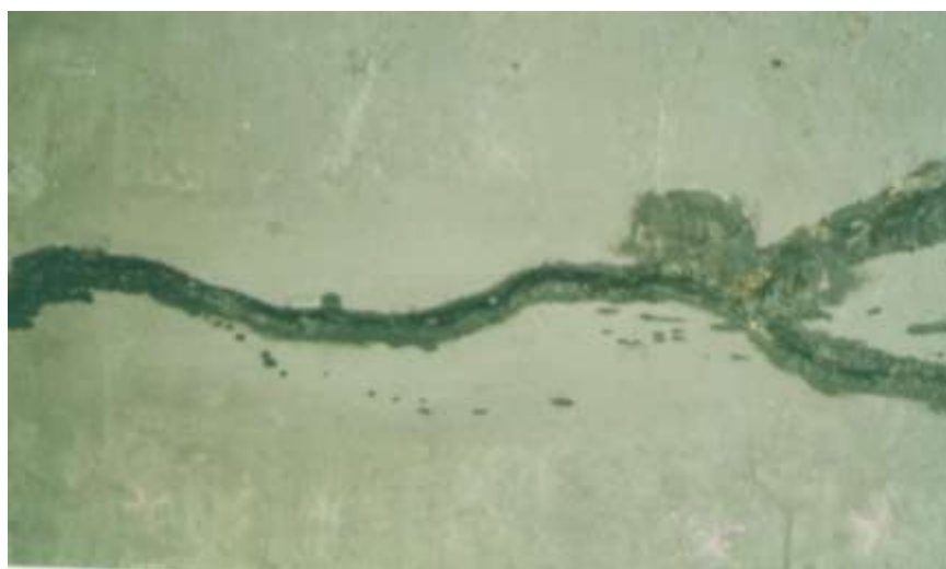
Рис 3. Грунтовка трещины с использованием полиуретановой композиции Монолит
