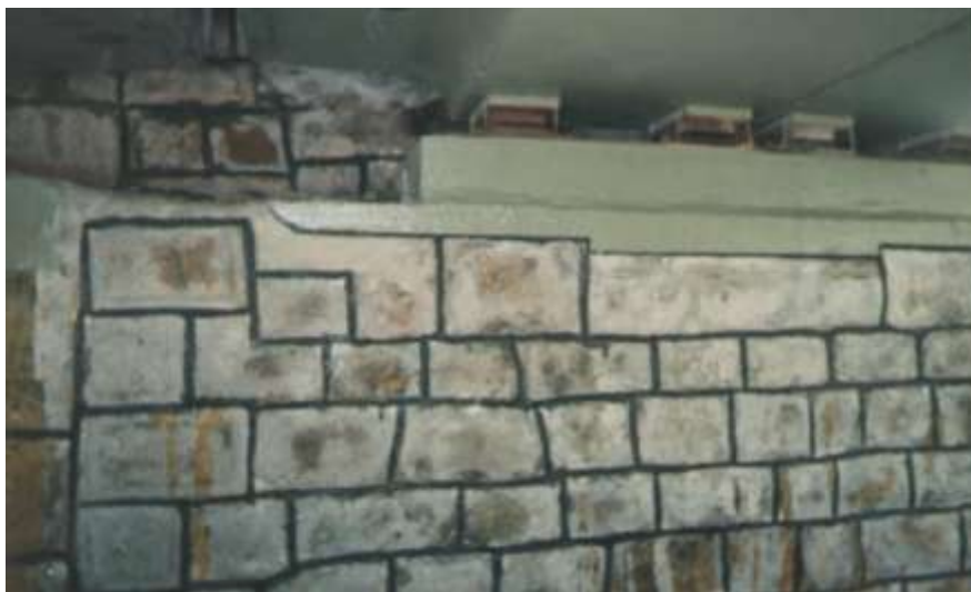
Рис 4. Каменная опора после ремонта с использованием комплекта материалов Монолит
