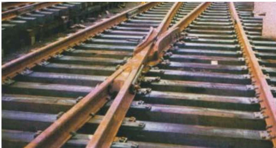
Рис. 7. Крестовина цельнолитая с отлитым контррельсом.
