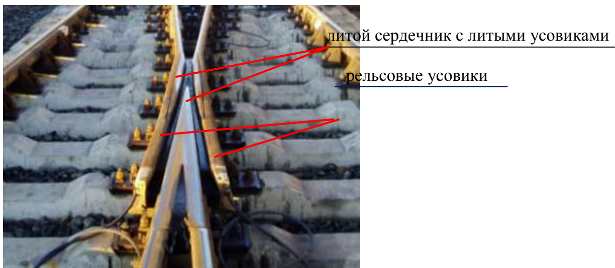
Рис. 3. Крестовина сборная с косой врезкой сердечника.
