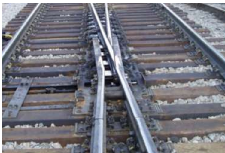
Рис. 10. Крестовина с непрерывной поверхностью катания с подвижным сердечником.
