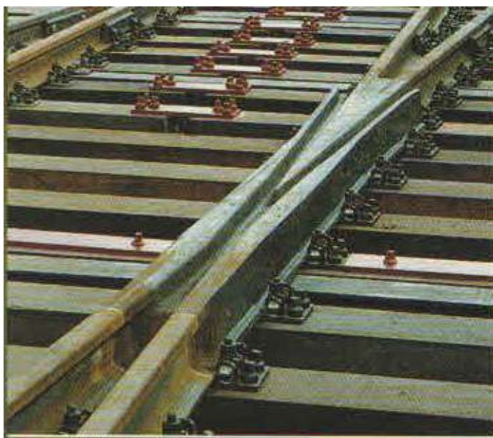
Рис. 6. Крестовина цельнолитая с четырьмя приварными рельсовыми окончаниями.
