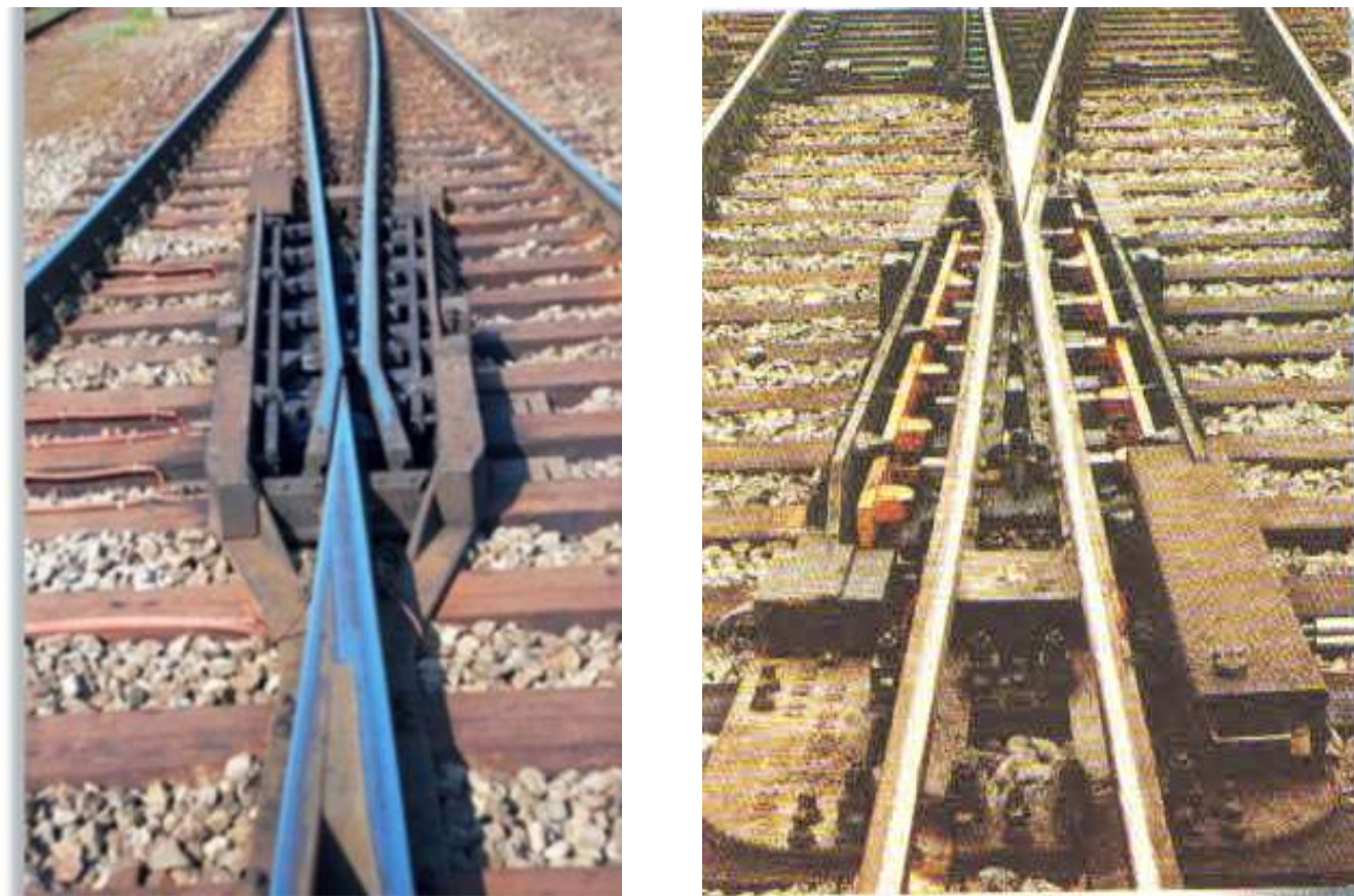
Рис. 12. Крестовины с подвижными усовиками.
