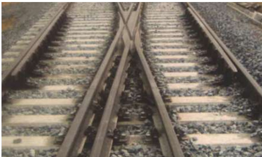
Рис. 8. Крестовина пересечения совмещенной колеи 1435 мм с колеей 1520 мм.
