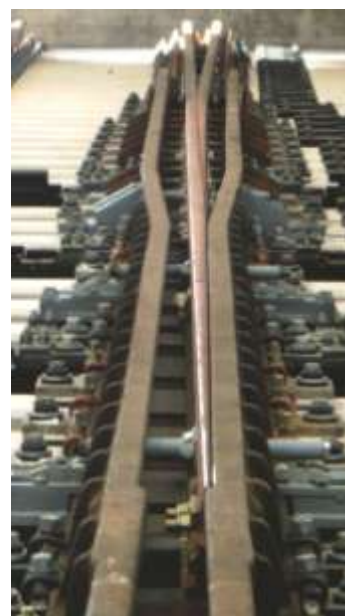
Рис. 11. Конструктивные варианты крестовин с подвижным сердечником.
