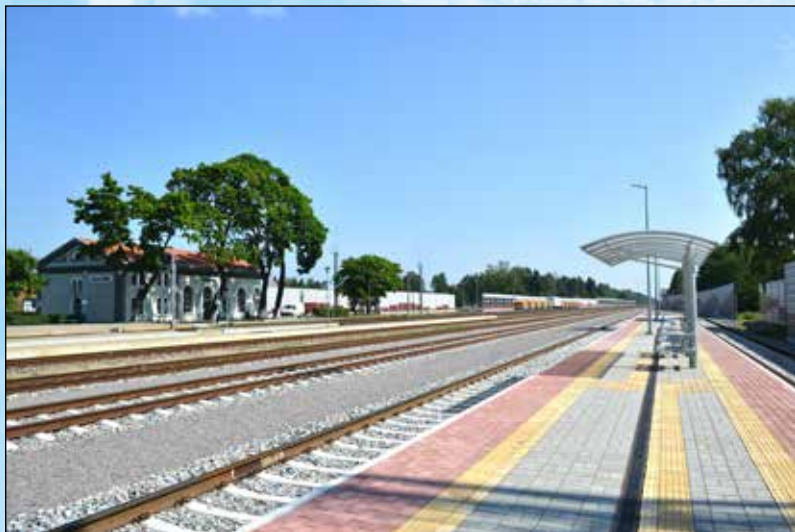
在“波罗的海铁路”项目框架下建成的现代化铁路客运站台(立陶宛铁路)
