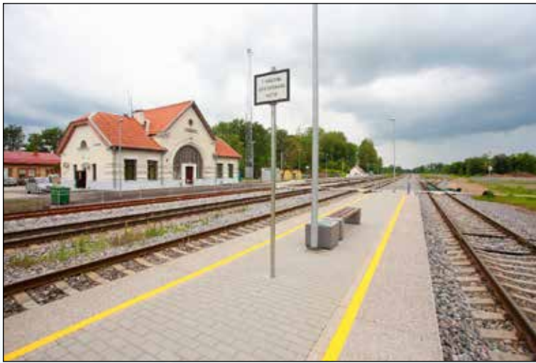
改造后的科克涅谢车站站台(立陶宛铁路)
