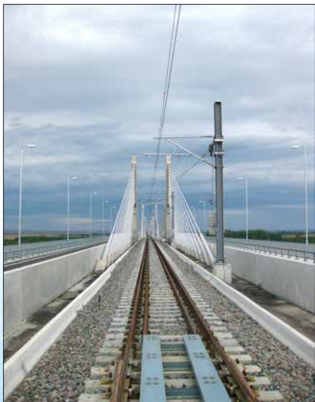
维丁(保加利亚)—卡拉法特(罗马尼亚)线路上的多瑙河“新欧洲”大桥
