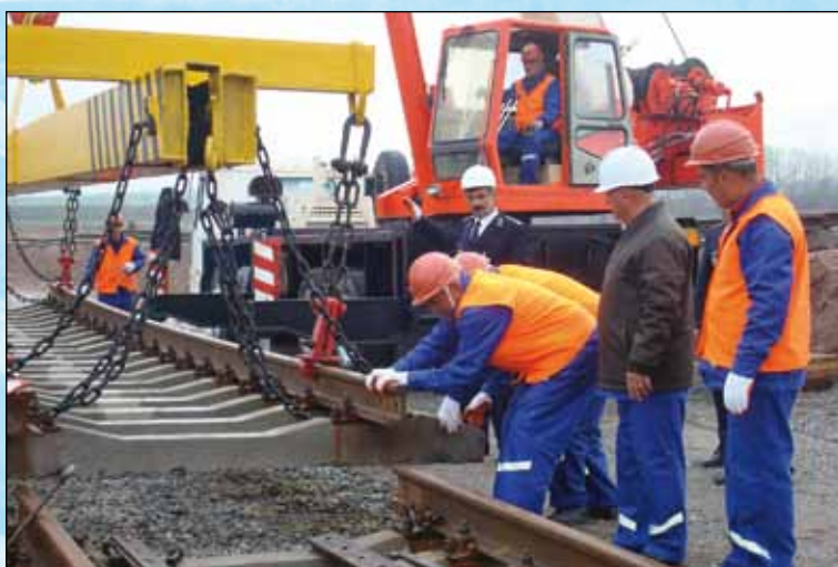
Укладка первого звена железнодорожной линии Яван – Вахдат (Таджикистан)
