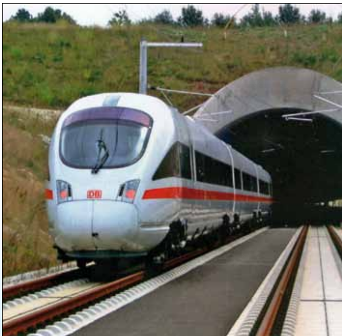
Участок дороги для движения высокоскоростных поездов ICE АО «Немецкая железная дорога» (наблюдатель ОСЖД) Нюрнберг – Ингольштадт, построенный компанией Max Bögl (присоединённое предприятие ОСЖД, Германия)
