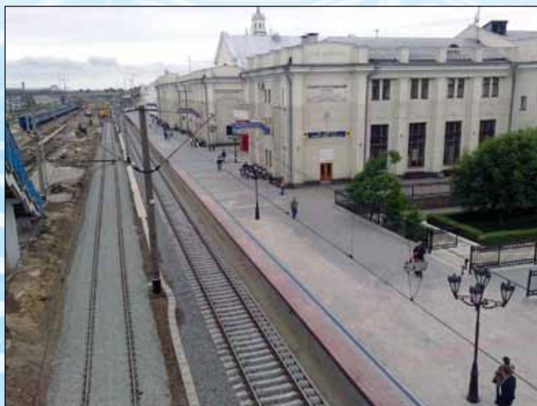
Реконструкция железнодорожных путей и платформ на станции Брест-Центральный (БЧ)
