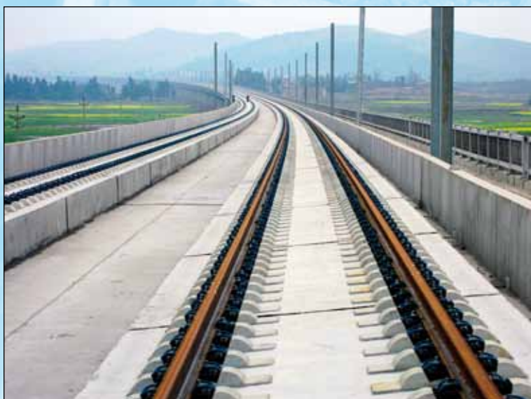
Одна из строящихся новых высокоскоростных линий КЖД (Китай)
