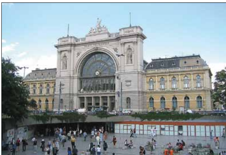
Железнодорожный вокзал Келети в Будапеште после реконструкции (Венгрия)
