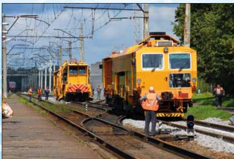
Путевые работы на Латвийской железной дороге (ЛДЗ)
