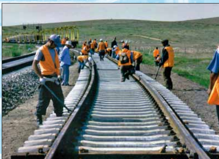
Модернизация верхнего строения пути на участке Улан-Батор – Замын-Уд (МТЗ)
