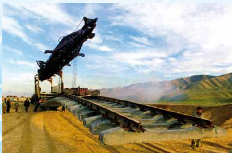
Прокладка новой железнодорожной линии в Туркменистане
