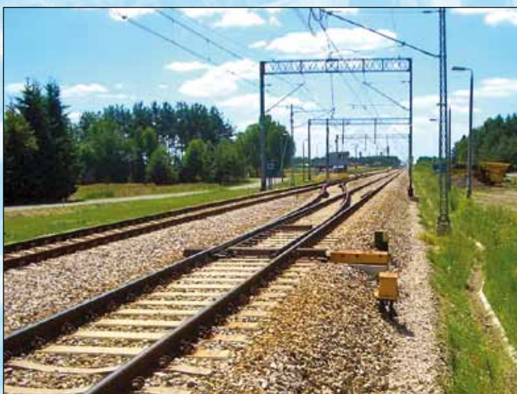
Модернизированные пути на участке ПКП Седльце – Тересполь (Польша) коридора ОСЖД №1
