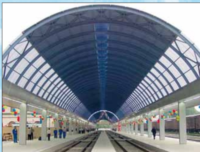
Новый крытый перрон на железнодорожном вокзале Кишинёва (ЧФМ, Молдова)
