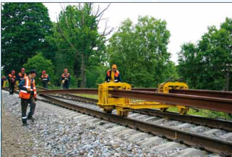
Модернизация железнодорожных путей на ЛДЗ (Латвия)
