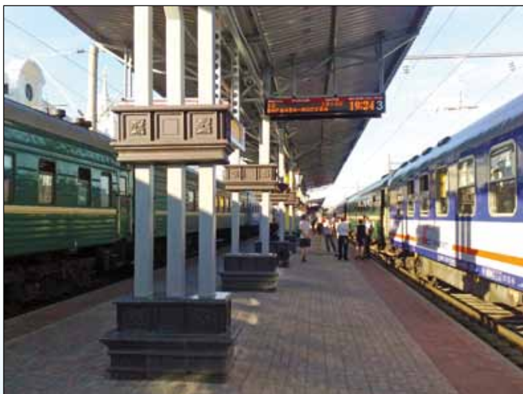
Платформы на станции Брест-Центральный после капитального ремонта (БЧ, Беларусь)
