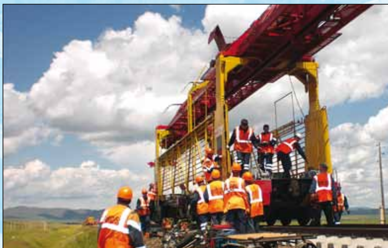
Путеремонтные работы на МТЗ (Монголия)
