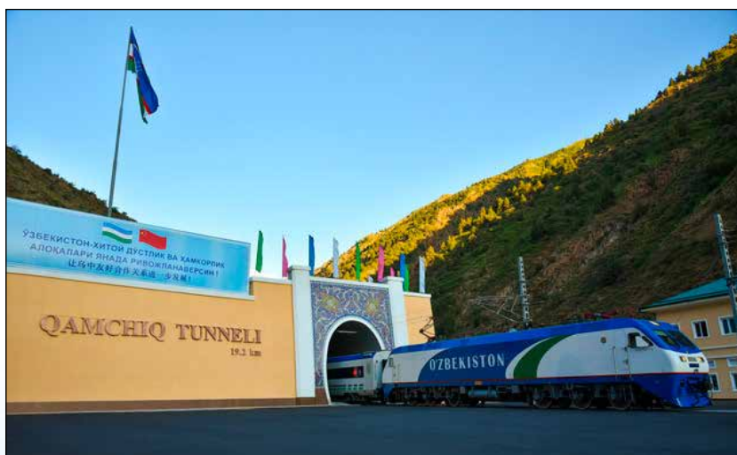
Торжественная церемония запуска электрифицированной железнодорожной линии Ангрэн – Пап и тоннеля в Узбекистане 22 июня 2016 года
