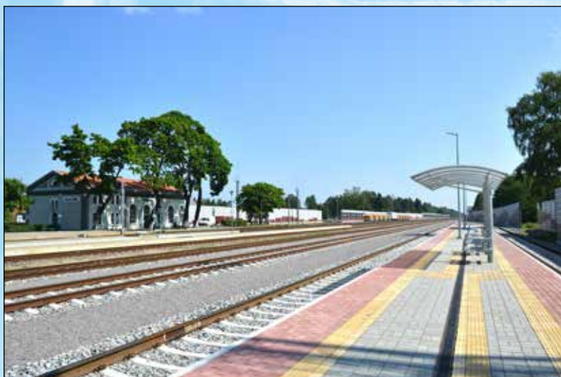
Новая пассажирская платформа на железнодорожной линии, построенной в рамках проекта «Rail Baltica» (Литовские железные дороги)
