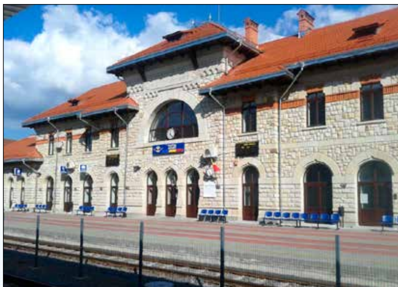
Здание железнодорожного вокзала на станции Пятра Неамц (Румыния) после модернизации
