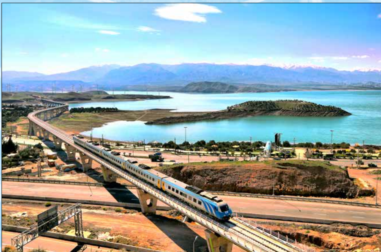
行驶在伊朗加兹温—拉什特新建铁路线上的第一列火车（图片由侯赛因·扎瓦迪提供）
