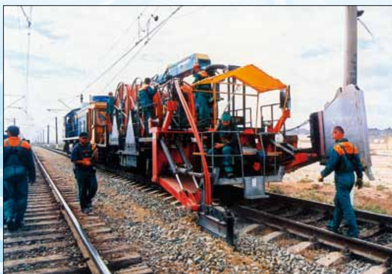
阿塞拜疆铁路上的线路作业
