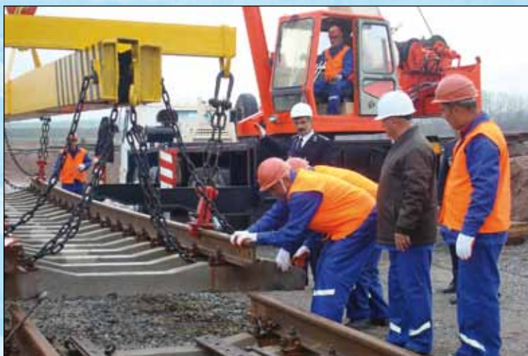
亚万—瓦赫达特铁路铺设第一组轨排（塔吉克斯坦）
