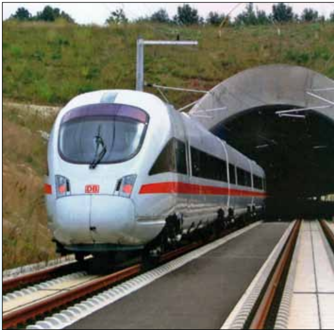
铁组加入企业—德国乌克斯博格公司 为德国铁路股份公司ICE型高速列车修建的 纽伦堡—因戈尔施塔特铁路区段
