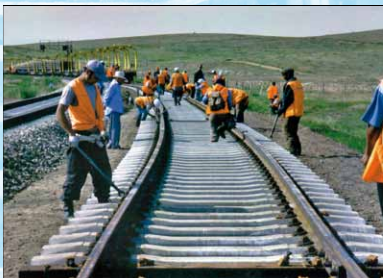
乌兰巴托—扎门乌德区段线路上部建筑现代化改造
