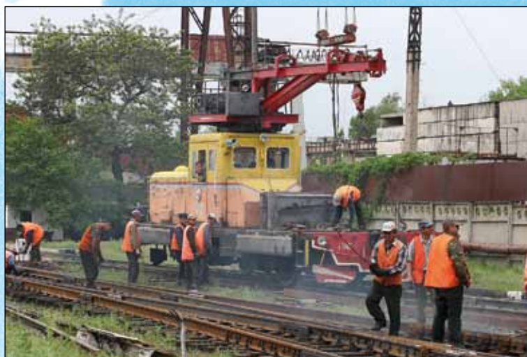
Путевые работы на железной дороге в Кыргызстане
