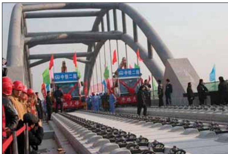
Завершающий этап строительства высокоскоростной линии Пекин – Тяньцзинь (КЖД, Китай)
