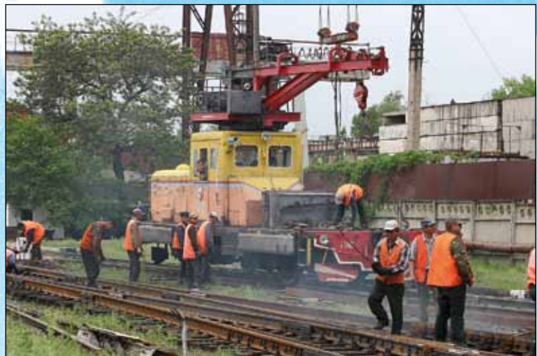
吉尔吉斯斯坦铁路上正在进行的线路作业
