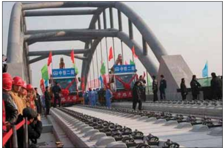
京津城际高速铁路全线铺通（中国）
