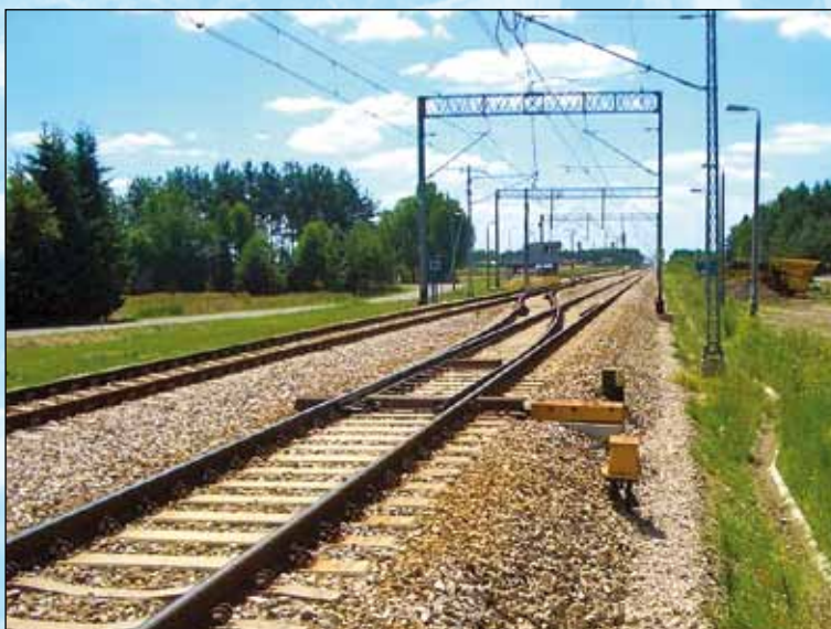
Modernisiertes Gleis auf der PKP Strecke Siedlce – Terespol (Polen) des OSShD-Korridors Nr. 1
