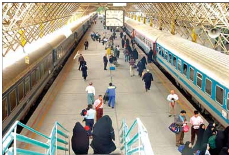
Bahnhof in Tehran (RAI, Iran)
