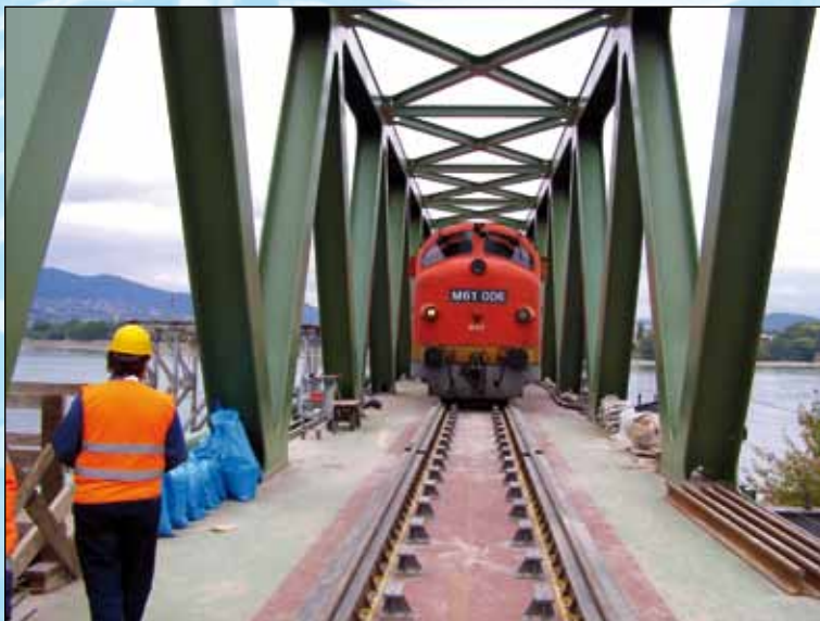
Öffnung der rekonstruierten Nord-Eisenbahnbrücke an Esztergom – Budapest Linie (Ungarn)
