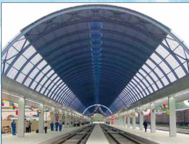
Der neue bedeckte Bahnsteig auf dem Chisinau Bahnhof (CFM, Moldova)
