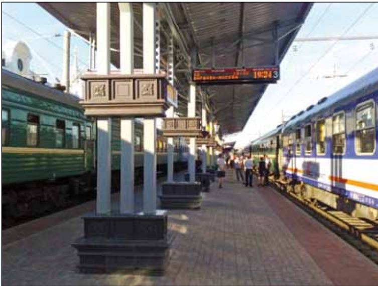
Bahnsteige am Brest-Central Bahnhof nach Hauptausbesserung (BC, Weißrussland)
