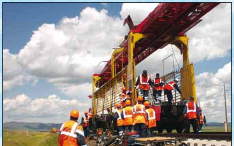
Gleisunterhaltungsarbeiten auf der MTZ (Mongolei)
