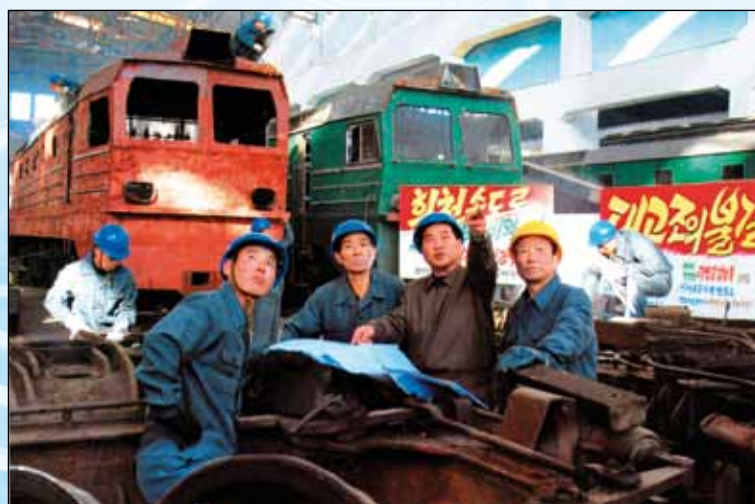
Generalreparatur der Fahrzeuge auf den ZC (KDVR)
