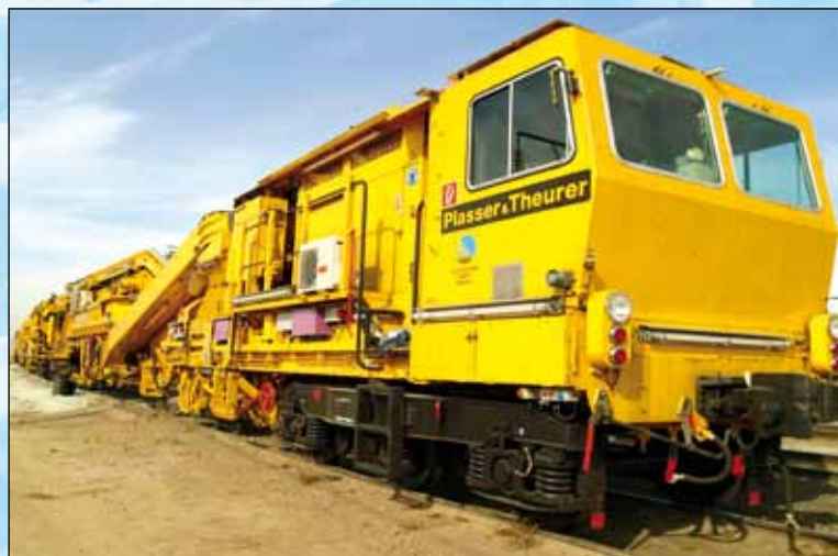
Die Gleisreparaturmaschine der Gesellschaft „Plasser und Theurer“ (OSShD angegliedertes Unternehmen, Österreich) auf der KZH Eisenbahn (Kasachstan)
