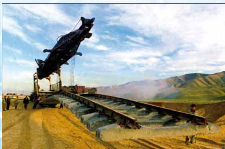
Verlegung der neuen Eisenbahnstrecke in Turkmenistan
