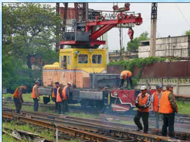
吉尔吉斯铁路线路维修作业
