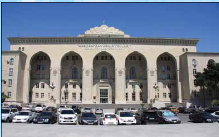
位于巴库的阿（塞）铁办公大楼
