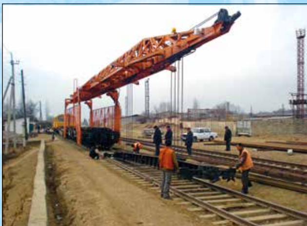
Ремонтно-путевые работы (Таджикистан, ТДЖ)
