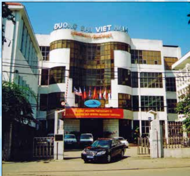
Здание администрации Вьетнамской железной дороги
