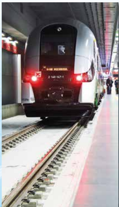
Блоки «Edilon Corkelast» АО «Tines» (Польша) в тоннельном пути на ст. Варшава-Аэропорт
