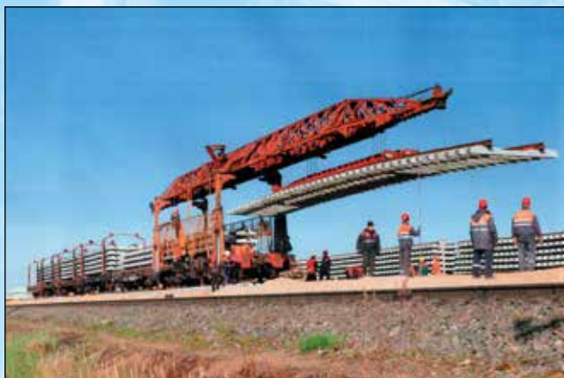
Прокладка железнодорожного пути (Латвия, ЛДЗ)
