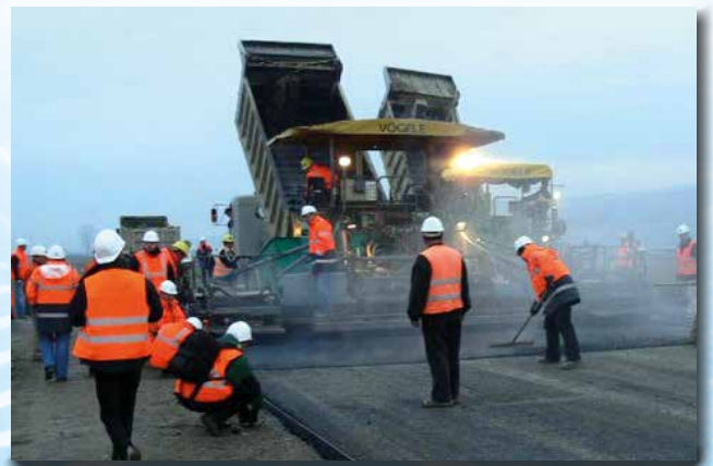
Дорожно-строительные работы ООО ФСК «МостГеоЦентр» (Россия)
