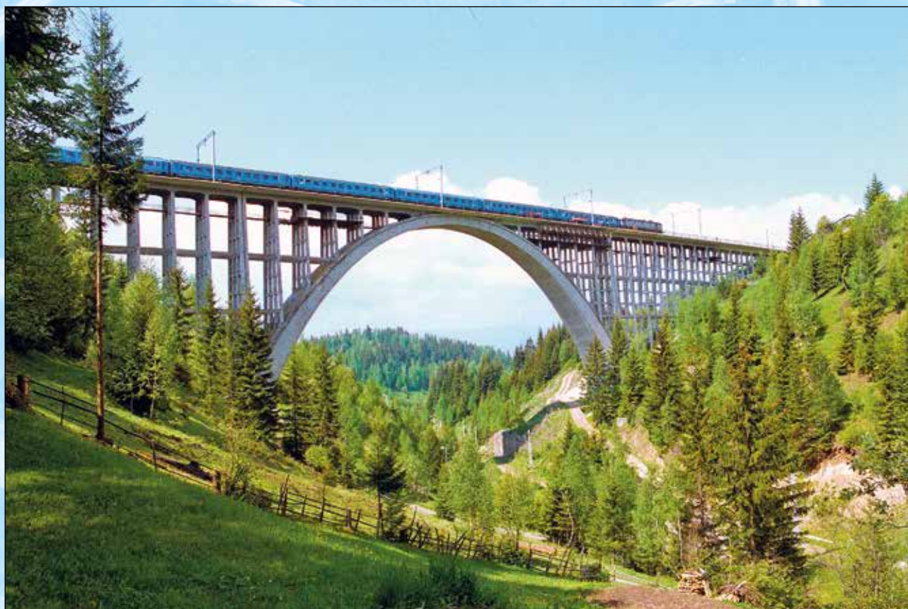
Железнодорожный мост на Румынских железных дорогах
