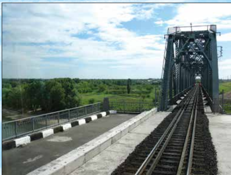
Железнодорожный мост на ЧФМ (Молдова)
