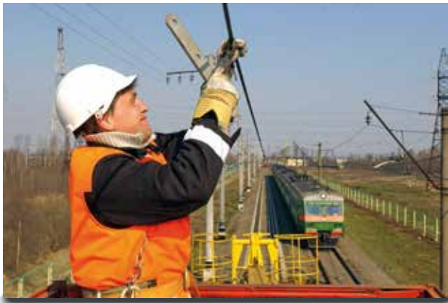
Ремонтные работы ЗАО «Компания «ТранТелеКом»» (Россия)
