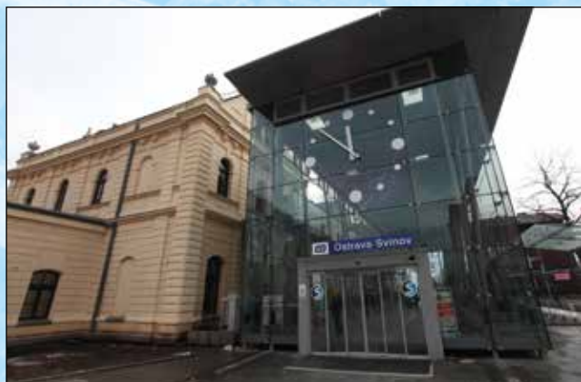
改造后的俄斯特拉发-斯维诺夫铁路车站 (捷克，捷铁)
