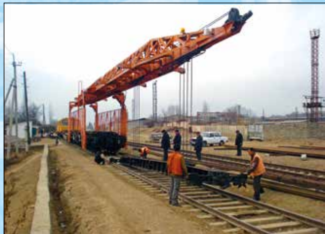
线路维修作业（塔吉克斯坦，塔铁）
