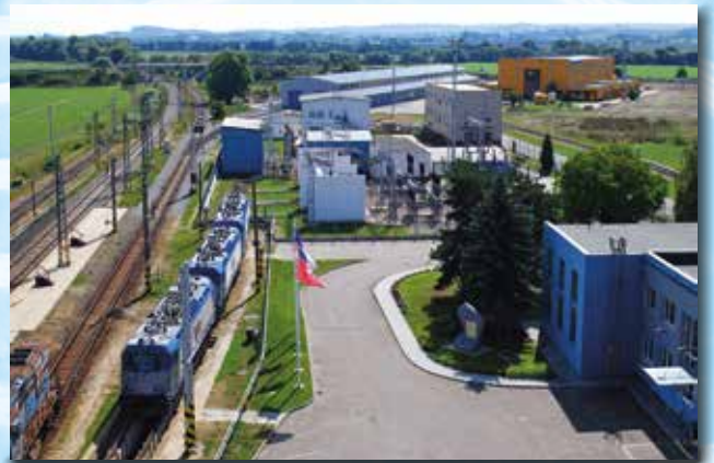
捷克铁路科学研究院股份公司VELIM试验环线
