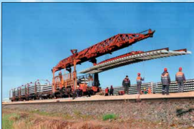
铁路线路铺轨现场（拉脱维亚，拉铁）
