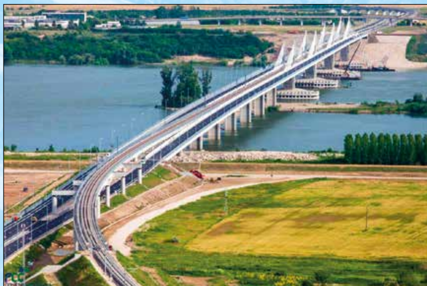
维丁市（保加利亚）和卡拉法特（罗马尼亚）市之间 新建的跨多瑙河公铁两用桥
