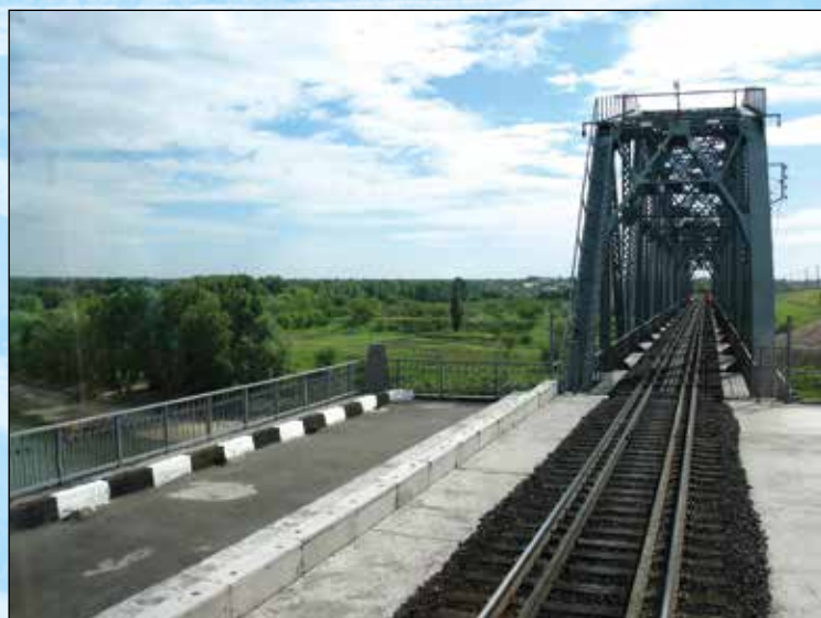
摩铁线路上的铁路桥（摩尔多瓦）
