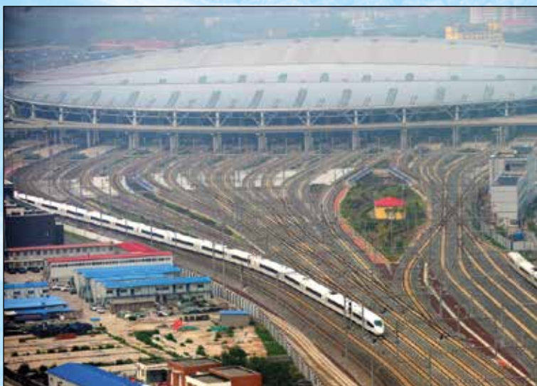
新落成的上海运输枢纽中的铁路车站 (中国，中铁)
