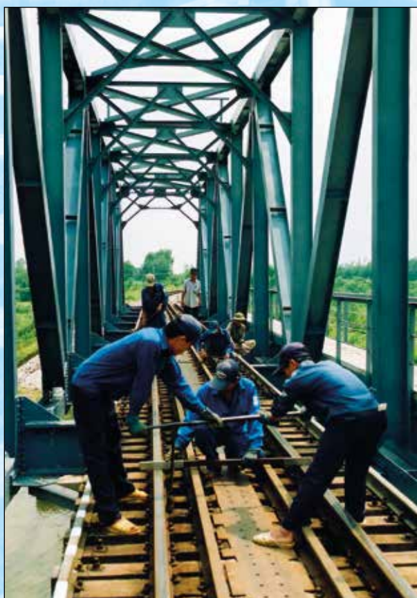
Путеремонтные работы (Вьетнамская железная дорога)
