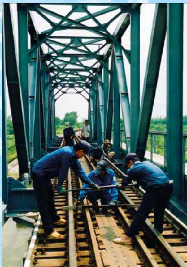
线路维修作业（越南铁路）
