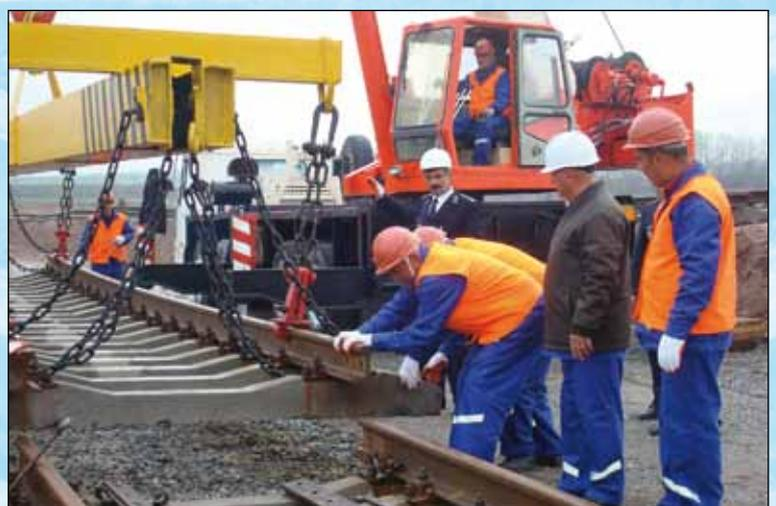
Verlegung des ersten Gleisjoches auf der Eisenbahnstrecke Jawan – Wachdat (Tadschikistan)
