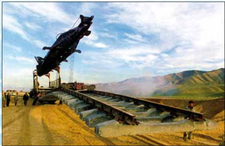
土库曼斯坦新建铁路铺轨
