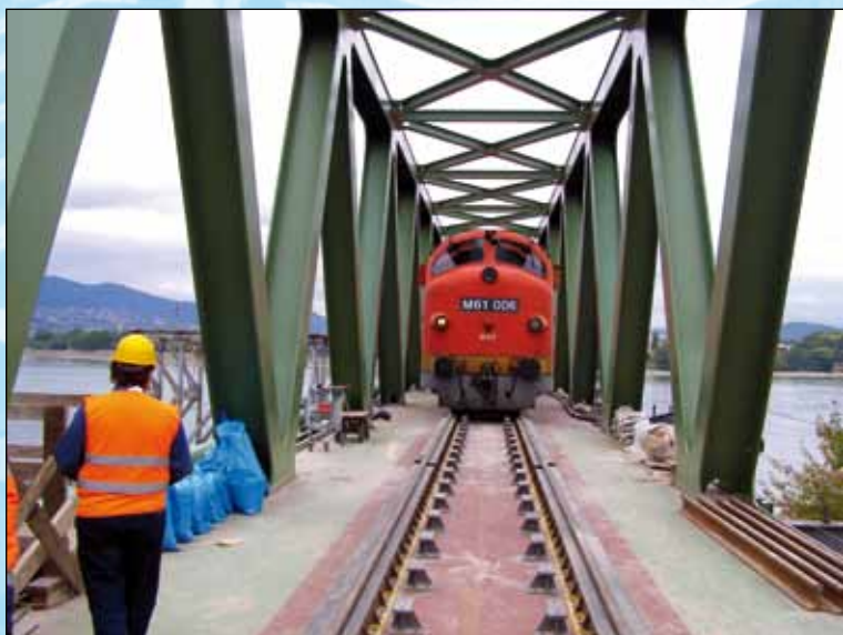
埃斯泰尔戈姆—布达佩斯线路上经过改造的 布达佩斯北铁路大桥开通行车
