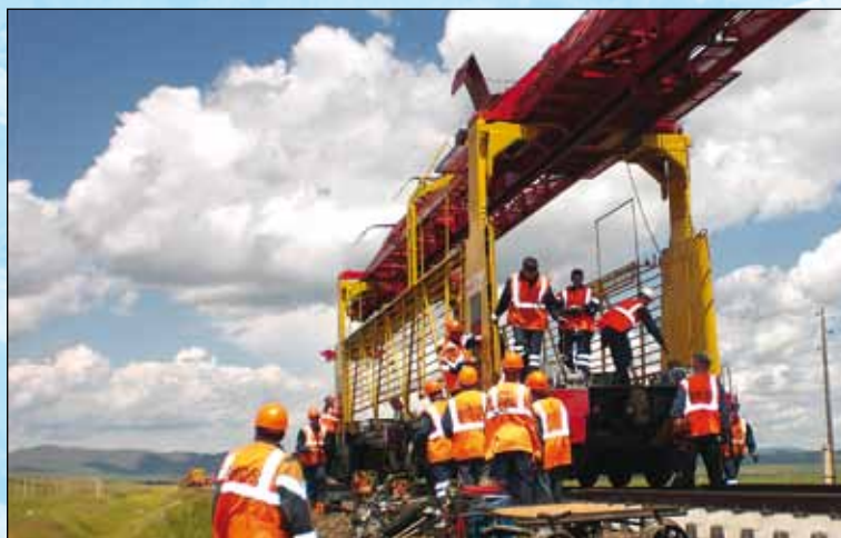
蒙铁（蒙古）的线路维修作业
