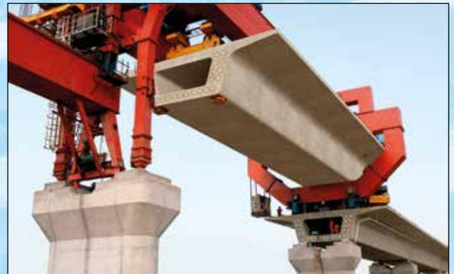
Операция по монтажу свободно-опорной балки весом 900 т и длиной 32 м на высокоскоростной магистрали Китайских железных дорог
